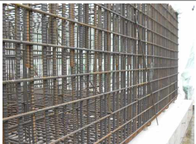
P4(상주방향) 기초 시공상태
