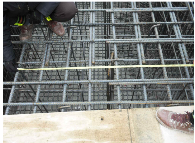
P3(영천방향) 기초상면 횡방향철근 간격측정(@200)
