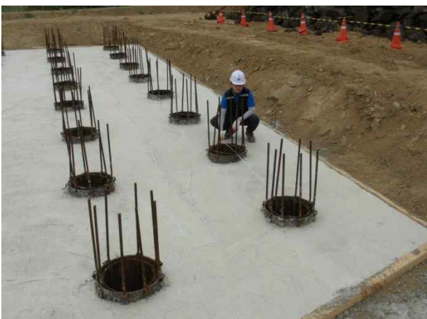
A2(상주방향) 기초 시공상태(2014.06.21)
