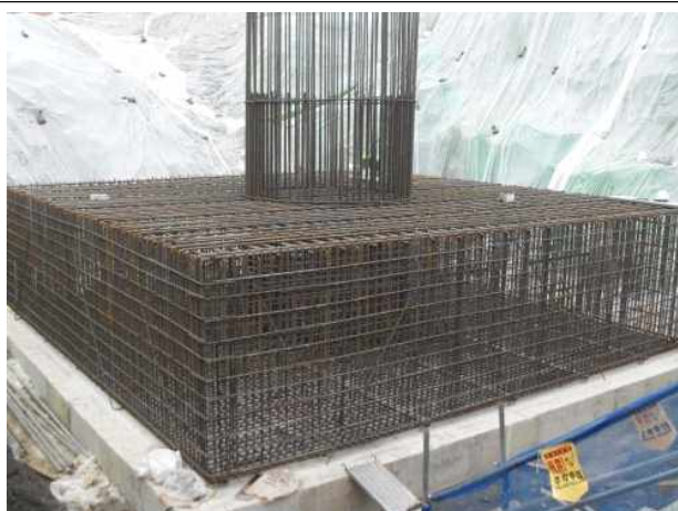
P4(상주방향) 기초 시공상태(2014.07.15)
