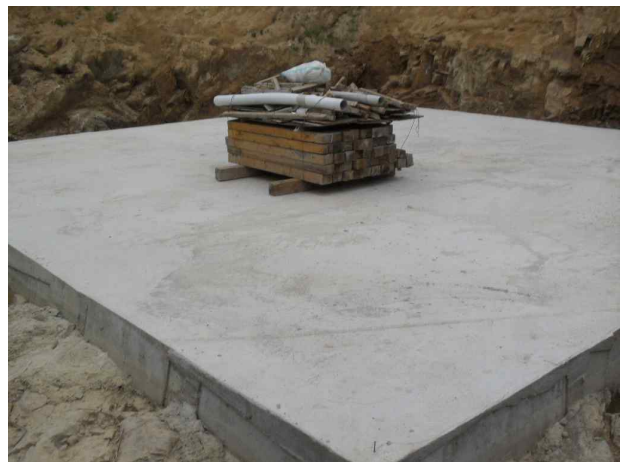
P2(영천방향) 버림 콘크리트 및 터파기 시공상태(2014.05.20)
