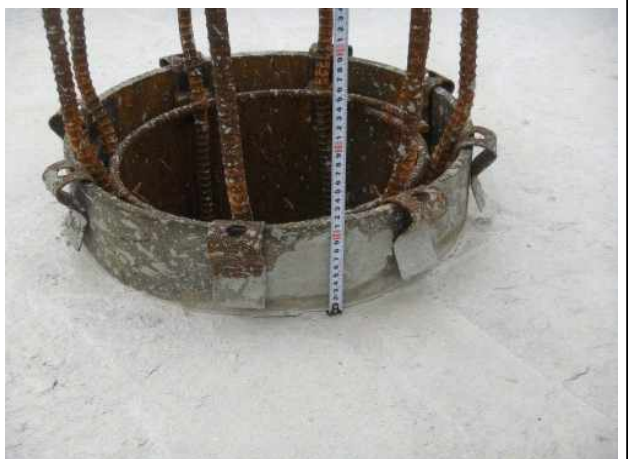
A2(상주방향) 버림콘크리트 및 기초 파일두부 상태
