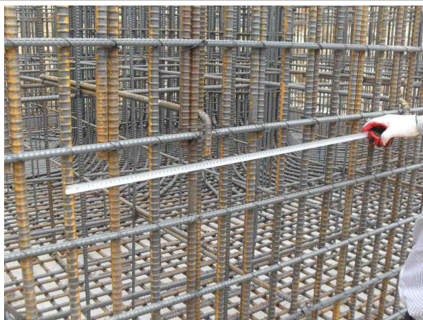
P1(영천방향) 기초 측면 수직철근 간격측정(@100)
