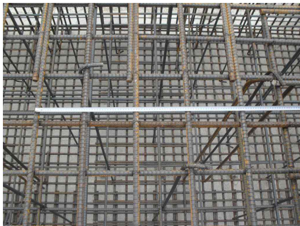
P1(영천방향) 기초 상단 종방향 철근 간격측정(@200)
