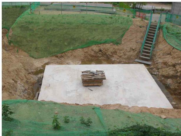
P2(영천방향) 버림 콘크리트 및 터파기 시공상태(2014.05.20)
