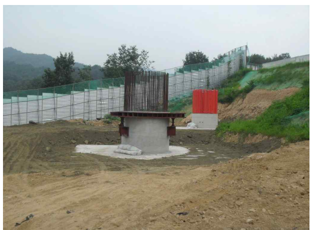
조치후) P1 주변 폐콘크리트 처리완료
