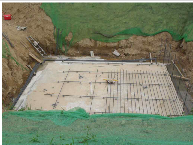
P2(상주방향) 버림 콘크리트 및 터파기 시공상태(2014.05.20)
