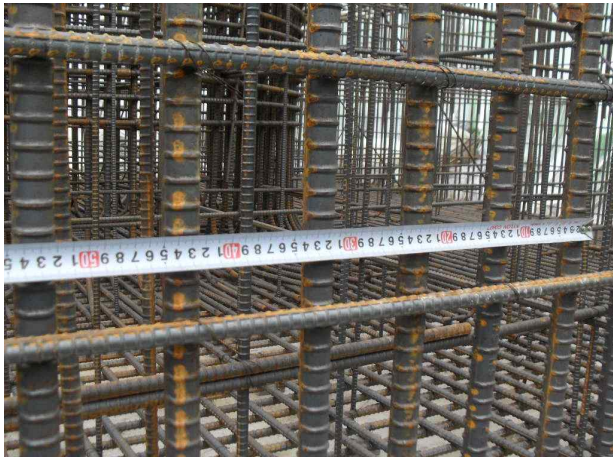
P4(상주방향) 기초측면 수직철근 간격측정(@100)
