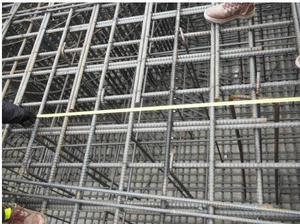
P3(영천방향) 기초상면 종방향철근 간격측정(@200)
