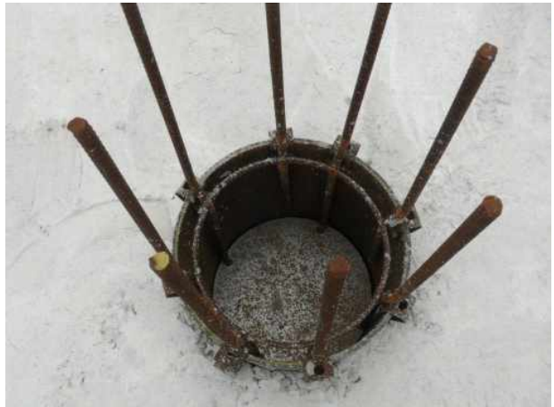
A2(영천 방향) 버림콘크리트 및 기초 파일두부 상태
