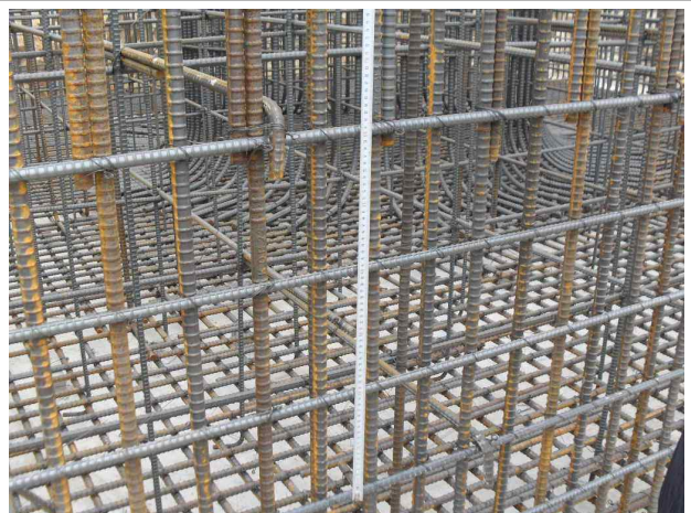
P1(영천방향) 기초 측면 수평철근 간격측정(@200)
