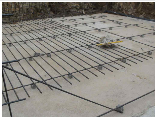
P2(상주방향) 버림 콘크리트 및 터파기 시공상태(2014.05.20)
