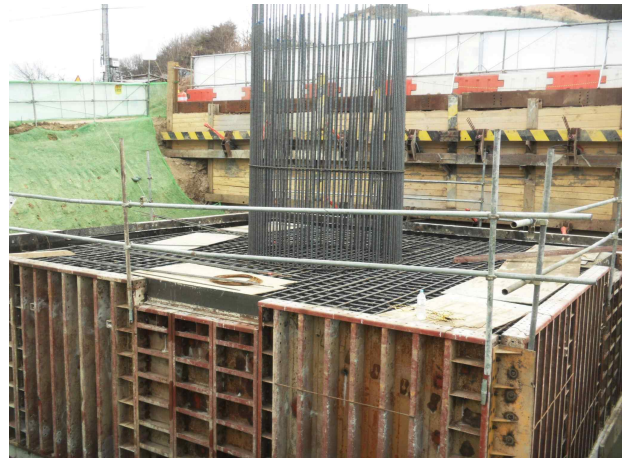
P3(영천방향) 기초 시공상태(2014.02.07)
