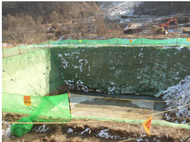
P3(상주방향) 기초 시공상태(2013.12.23)
