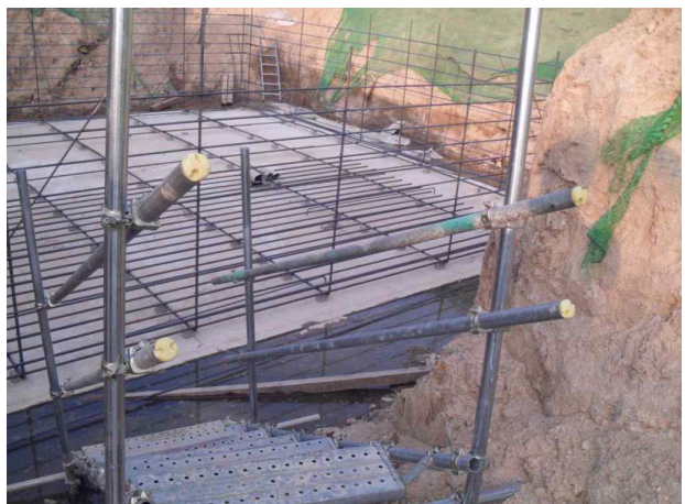
조치후) 가설계단 수평재 단부 보호캡 설치
