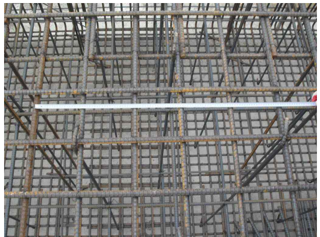
P1(영천방향) 기초 상단 횡방향 철근 간격측정(@200)
