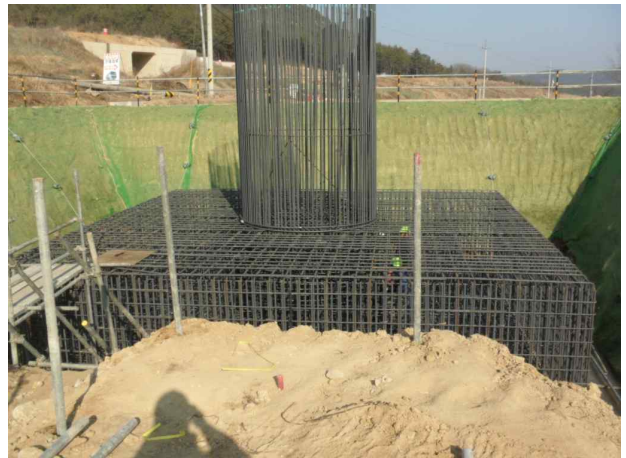
P3(상주방향) 기초 시공상태(2014.01.06)
