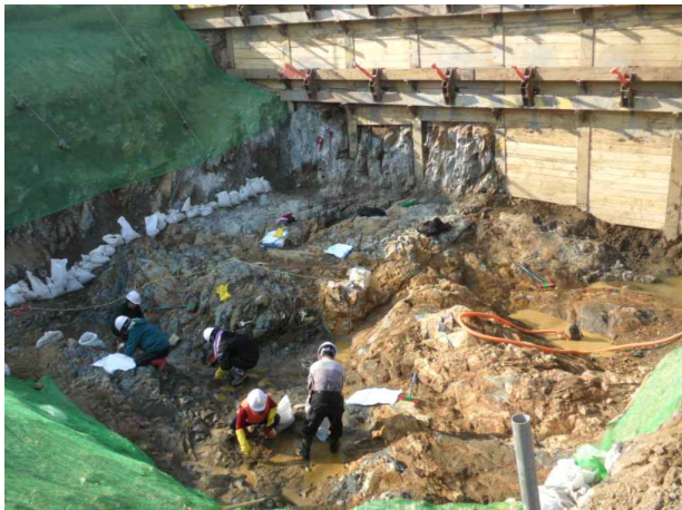
P3(영천방향) 기초 시공상태(2014.01.06)
