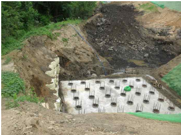
P4(영천방향) 기초 시공상태(2014.06.21)
