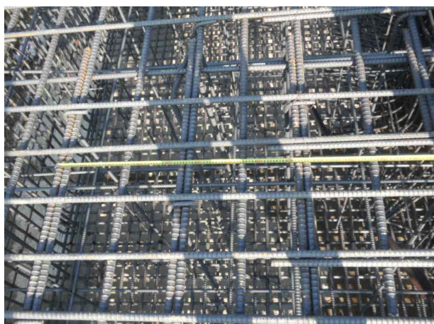
P3(상주방향) 기초상면 횡방향철근 간격측정(@200)
