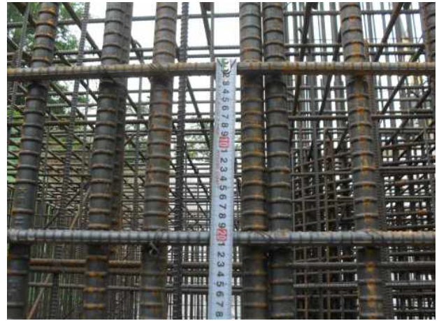
P4(상주방향) 기초측면 수평철근 간격측정(@200)
